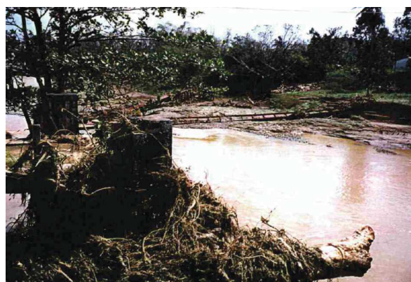
Figure 8 – Pont de la Boucan à Sainte-Rose détruit par le passage de Marilyn (BRGM)
